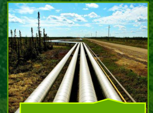
Protección de tuberías
