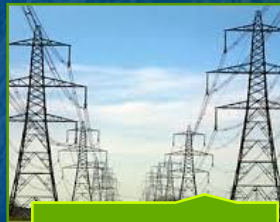
Infraestructura de energía, etc
